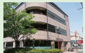
京田辺市商工会が入る 京田辺市商工会館
